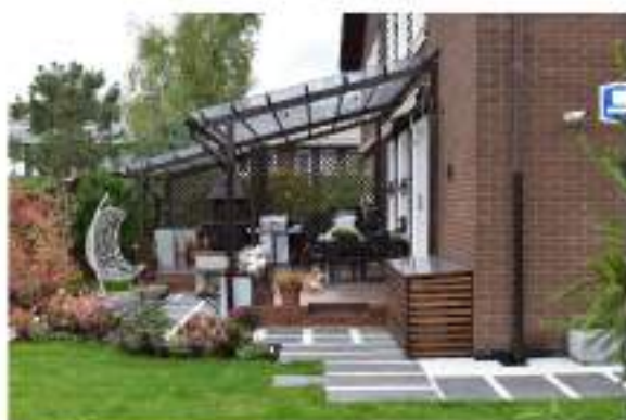
Фото объекта после благоустройства:
