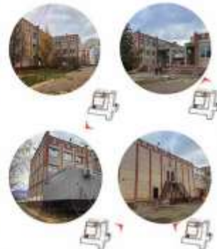
Фотофиксация существующего положения
